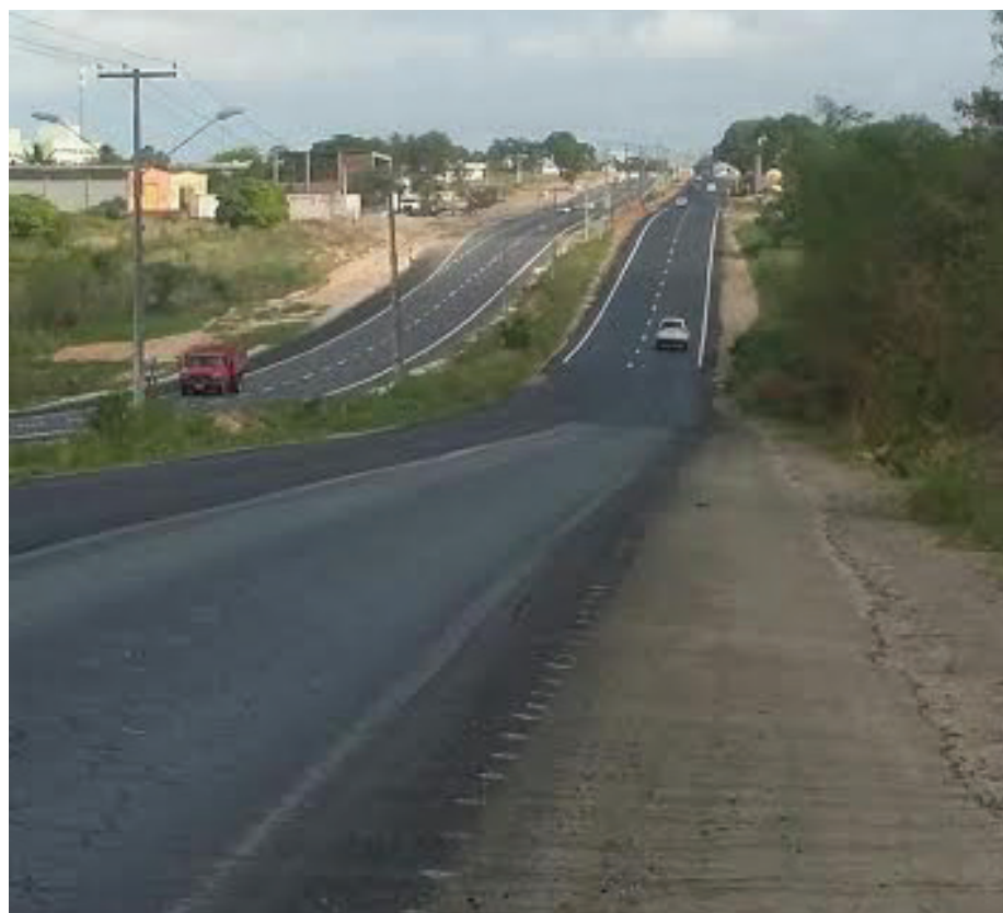
A obra compreende 12 km da BR-406, no entroncamento da BR-101, até o novo viaduto, entregue no ano passado
